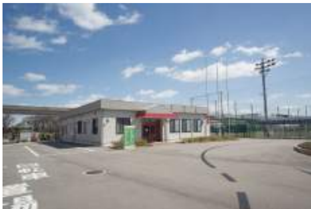
神戸レディースフットボールセンター
