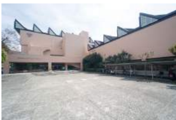
王子スポーツセンター
