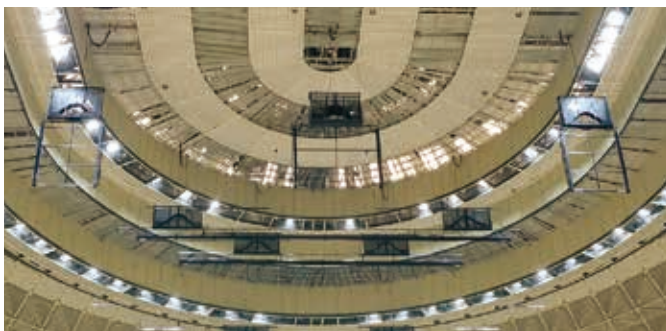
南側バトン Battens on south side
